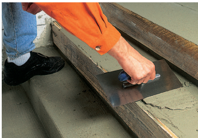
2. BRS – ремонт основания
