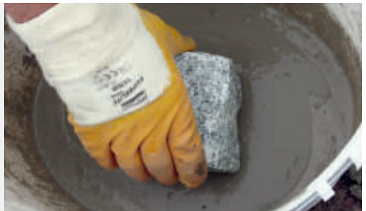
Раствор-шлам для повышения адгезии TNH rapid от tubag наносится непосредственно перед укладкой на нижнюю сторону камня или плиты. Для определенных конструкций раствор-шлам может быть нанесен на подстилающий слой распылением.
