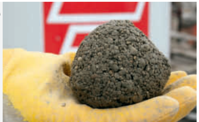
Так выглядит раствор для подстилающего слоя идеальной консистенции
