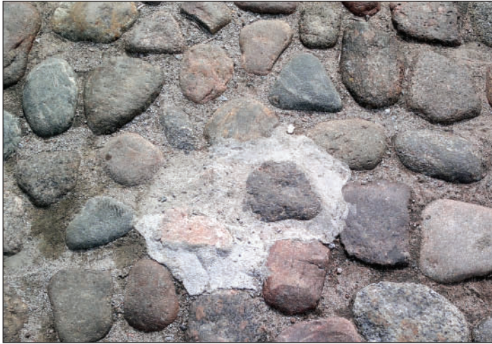
Рис. 57. Закрепление булыжных камней с помощью цементно-песчаного раствора не является эффективным
