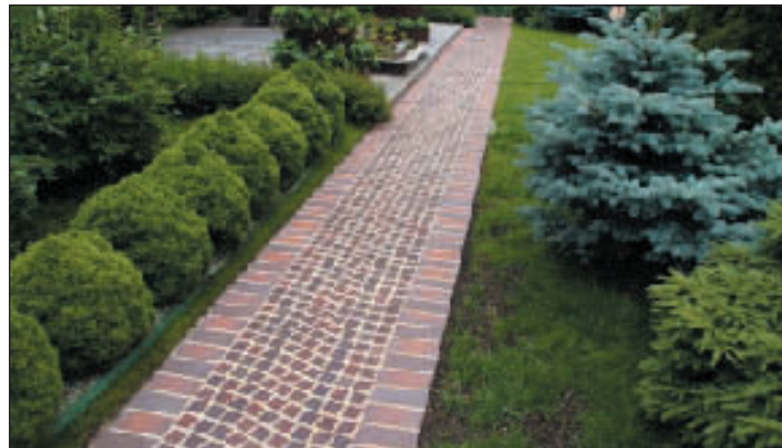
Рис. 66. Коттеджный пос. (Московская обл.). Использование раствора для заполнения швов контрастного (относительно мощения) цвета (цвет песчаный), позволяет подчеркнуть рисунок покрытия.
