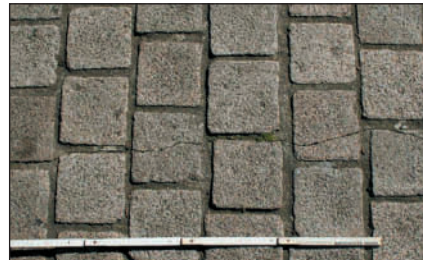
Рис. 20. Трещины в связанных покрытиях от температурных напряжений.
