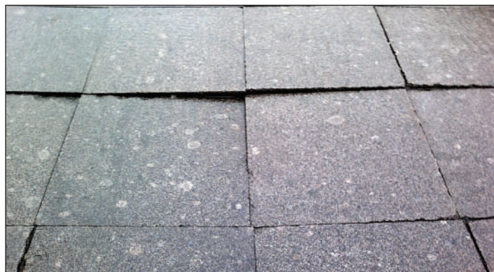
Рис. 9. Крупные плиты не устойчивы в покрытии
