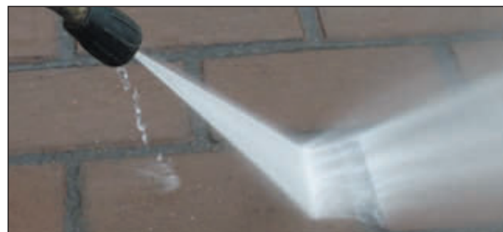
Рис. 40. Очистка клинкера водой под высоким давлением. Внимание! Надо следить, чтобы раствор в швах не размывался!
