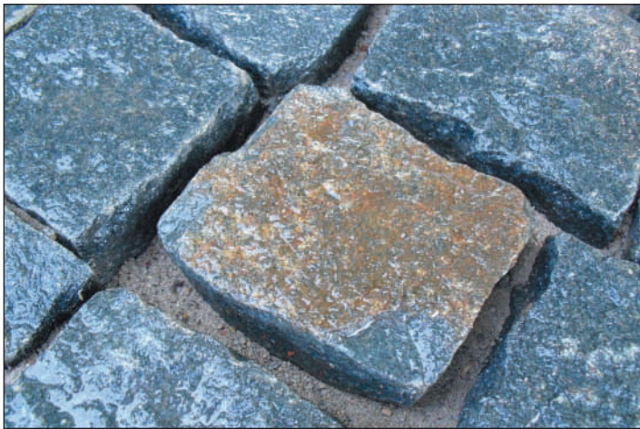
Расшивка швов на глубину не менее 30 мм
