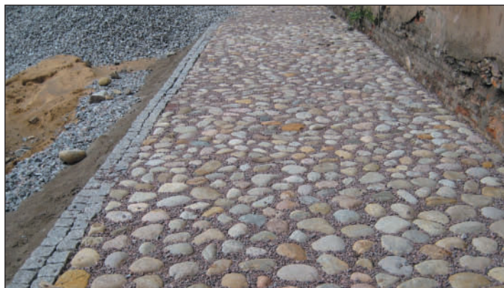
Рис. 52. Мощение булыжником. Процесс выполнения работ (2007 г.)
