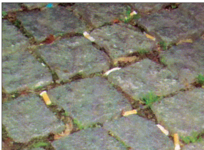
Рис. 3. Незаполненные швы ухудшают эксплуатационные и эстетические качества мощения
