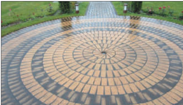
Рис. 65. Частный дом (Казань). Для заполнения швов использовался водонепроницаемый раствор. Применение раствора для заполнения швов позволило надежно заполнить большие швы, которые возникли при мощении прямоугольным клинкером по кругу.
