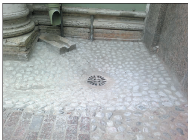
Рис. 30. Некачественная очистка мощения после заполнения швов водонепроницаемым раствором (Большой двор Зимнего дворца, Санкт-Петербург, 2015 г.).
