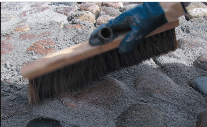
Очистка булыжника. Удаление остатка раствора щеткой
