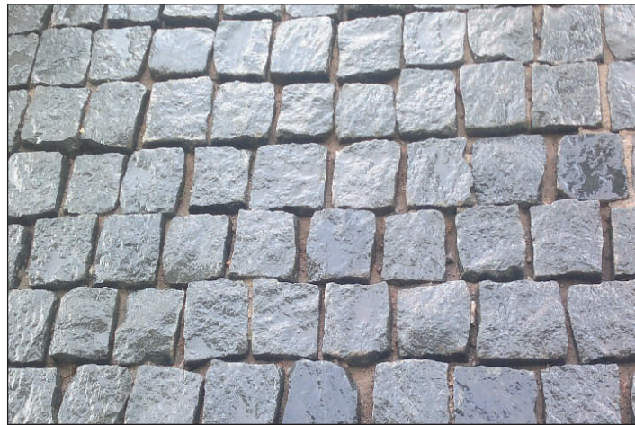
Расшивка швов на глубину не менее 30 мм
