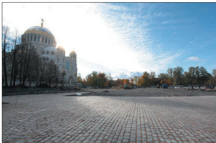
Рис. 75. Мощение северной части Якорной площади
