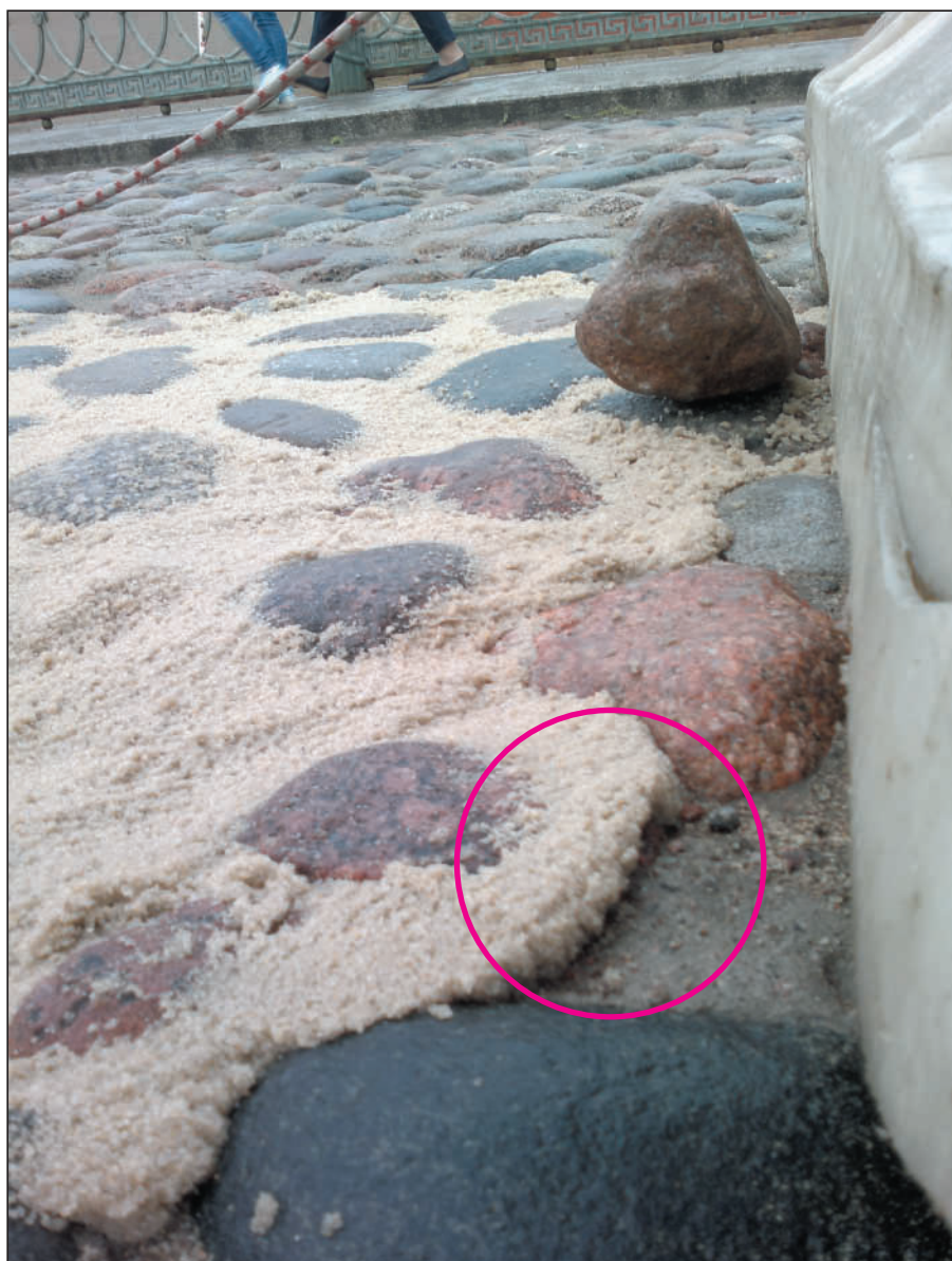
Рис. 36 (а). Заполнение швов водопроницаемыми растворами PFL (Петропавловская крепость, 2015 г): а- расшивка швов и предварительное увлажнение; б)-заполнение швов.
