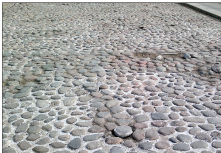
Рис. 56. Мощение булыжником. Процесс выполнения работ (2007 г.)
