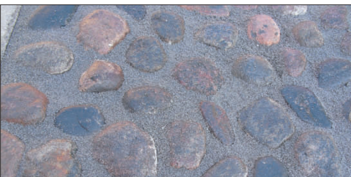
Вид мощения после заполнения швов
