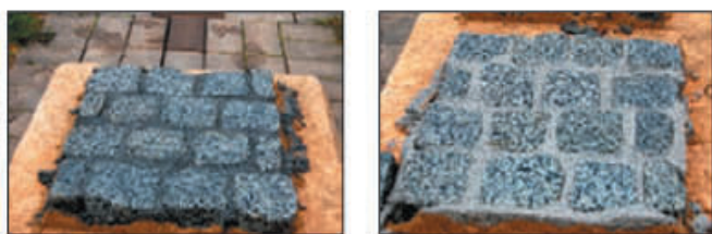
Рис. 33. Перед началом работ на всей площади мощения рекомендуется выполнить небольшие фрагменты покрытий (тестовые участки) для отработки технологии и уточнения ожидаемого эстетического эффекта от цвета раствора.
