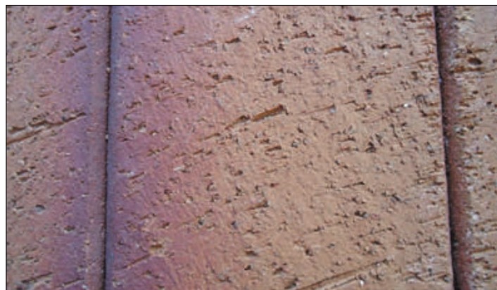
Рис. 38. Раковины на лицевой поверхности клинкера
