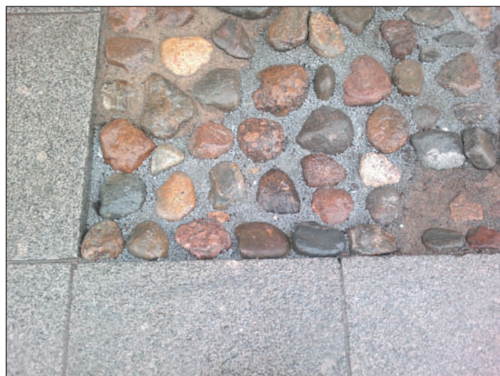
Ремонт мощения, находящегося в зоне интенсивного пешеходного движения (на "срезах" углов).
