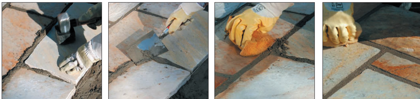
Рис. 43. ПМощение с применением растворов NVL.
