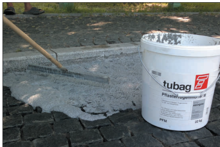
Распределение по поверхности дорожного покрытия водопроницаемого раствора PFM с тщательным заполнением швов
