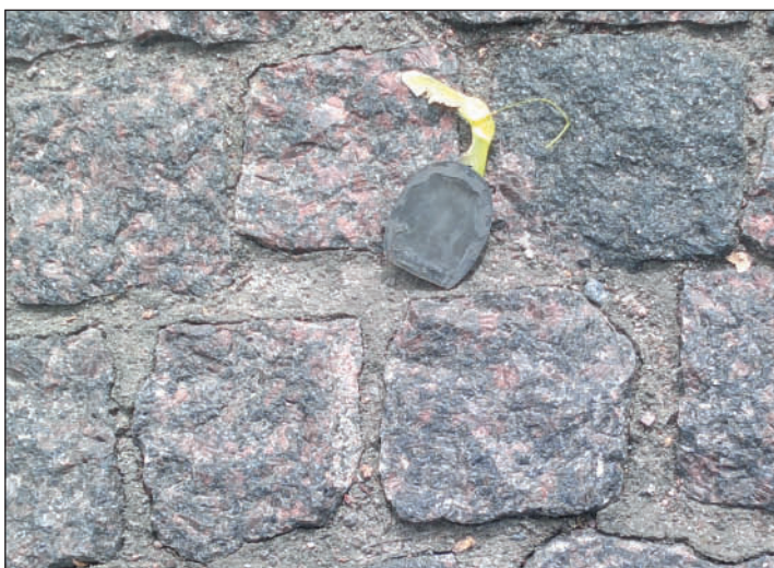
Рис. 3. Незаполненные швы ухудшают эксплуатационные и эстетические качества мощения
