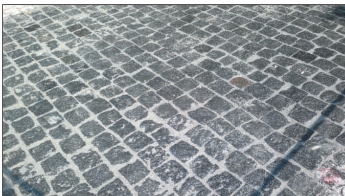
Рис. 37. Технология заполнения швов водопроницаемым раствором PFM (Петропавловская крепость, Санкт-Петербург)
