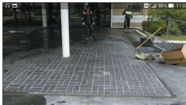
Рис. 28. Белесый налет в швах вызван застоем воды в них во время очистки поверхности мощения (табачная фабрика “Петро”).
