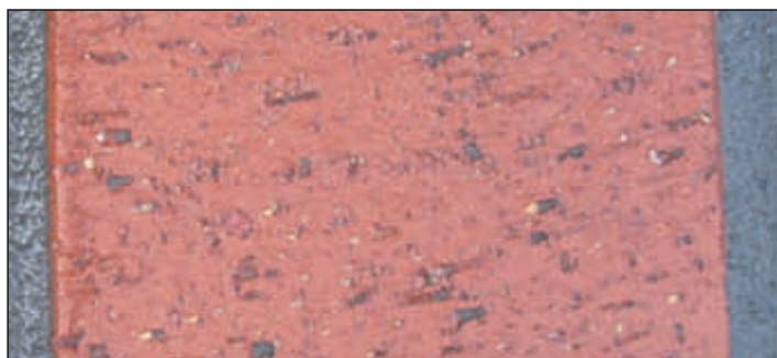
Рис. 39. Остатки шовного раствора в раковинах и кавернах клинкера
