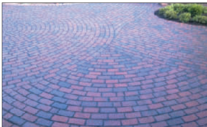
Рис. 63. Частный дом. (Краснодарский край) Для заполнения швов использовался водонепроницаемый раствор PFL (цвет-базальт).
