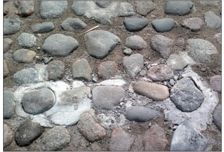
Рис. 57. Закрепление булыжных камней с помощью цементно-песчаного раствора не является эффективным
