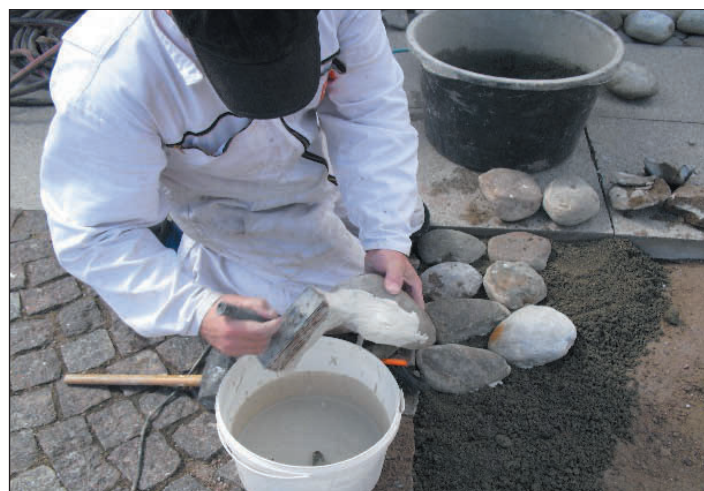
Обработка основания булыжника адгезионным раствором
