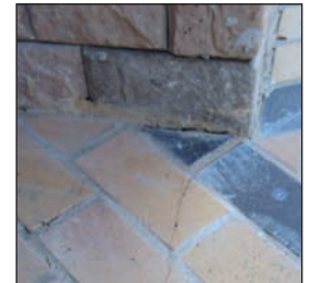
Рис. 20. Трещины в связанных покрытиях от температурных напряжений.
