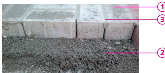
Рис. 44 Дорожное покрытие из искусственных камней мощения с использованием растворов на основе вяжущих: 1 - камни мощения; 2 - подстилающий слой из дренажного раствора; 3-заполнение швов из водопроницаемого раствора.
