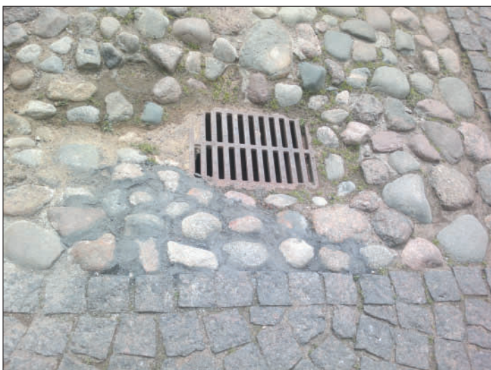
Ремонт мощения, примыкающего к водосборному колодцу.
