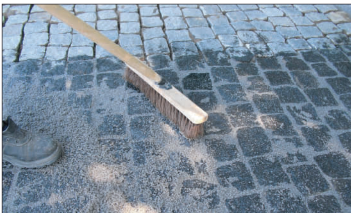
Подметание поверхности мощения щеткой
