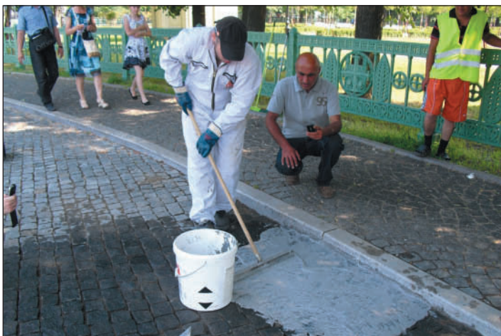
Распределение по поверхности дорожного покрытия водопроницаемого раствора PFM с тщательным заполнением швов
