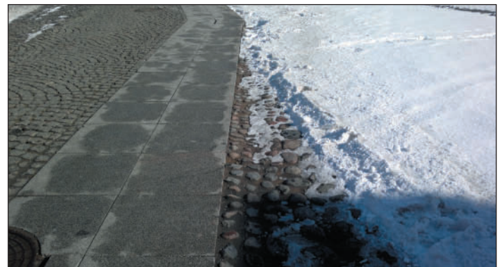
Рис. 59. Зимняя уборка участка мощения, выполненного с применением растворов на основе вяжущих, не вызывает проблем с материалом заполнения швов, который при традиционном исполнении конструкции выносится из покрытия.
