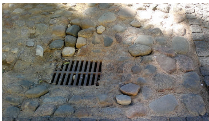
Рис. 54. Мощение булыжником. Процесс выполнения работ (2007 г.)
