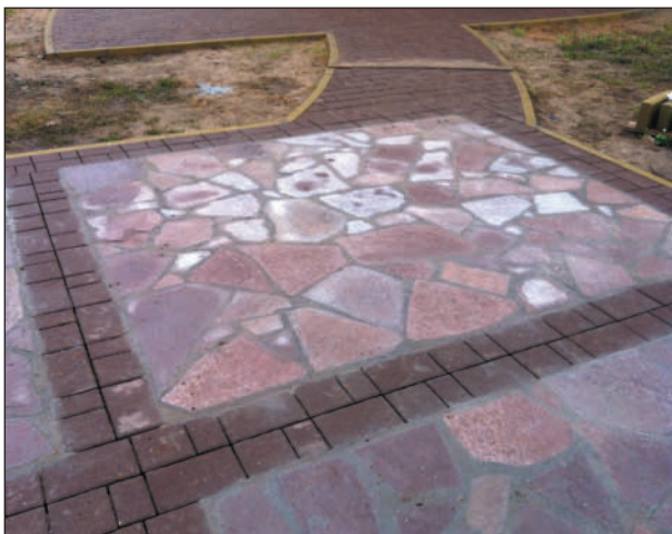
Рис. 65. Частный дом (Казань). Для заполнения швов использовался водонепроницаемый раствор. Применение раствора для заполнения швов позволило надежно заполнить большие швы, которые возникли при мощении прямоугольным клинкером по кругу.
