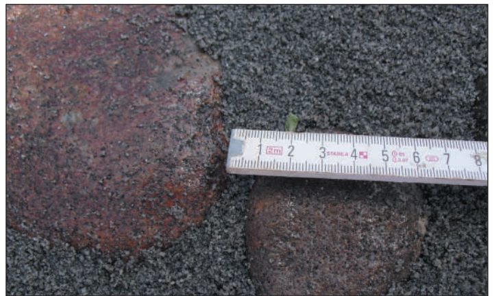
Увеличенные швы способствуют большому расходу раствора
