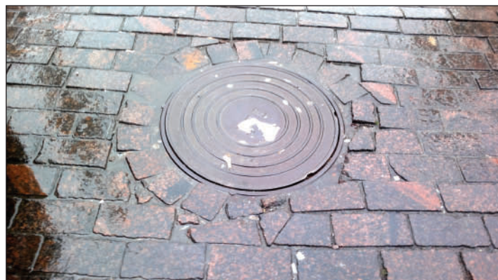
Рис.11. При мощении не соблюдаются правила выполнения примыканий
