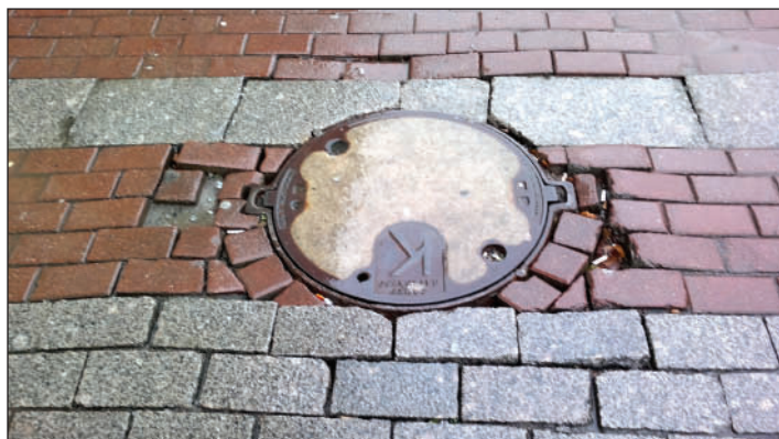
Рис.11. При мощении не соблюдаются правила выполнения примыканий
