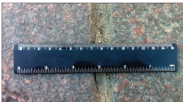
Рис. 7. Мощение прямолинейными рядами из гранитной шашки. Швы 15- 25 мм.
