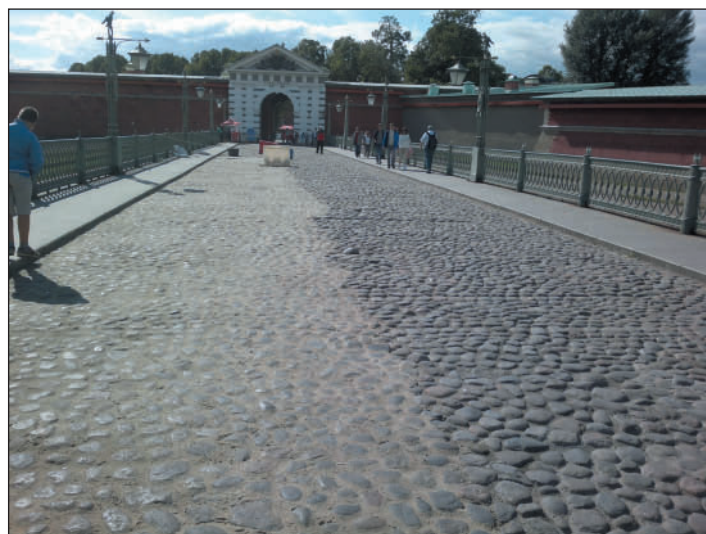
Дорога в Петропавловскую крепость от Иоанновского моста. Процесс выполнения работ. Левая часть фото - мощение с заполнением швов растворами, правая - с традиционным заполнением из песка.
