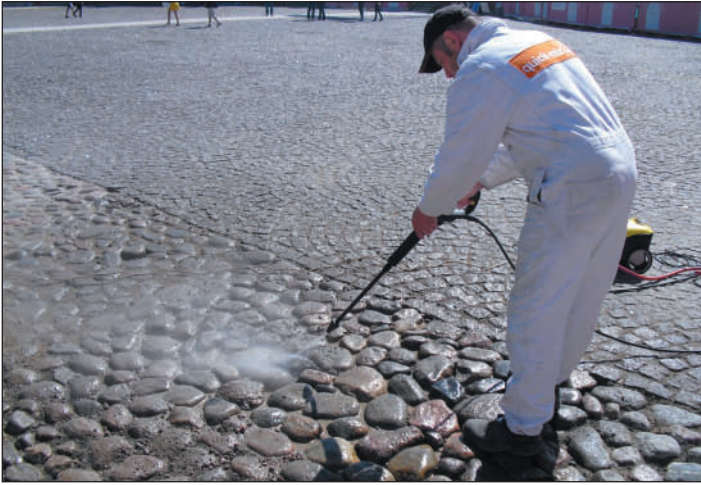
Расшивка швов факелом воды под высоким давлением
