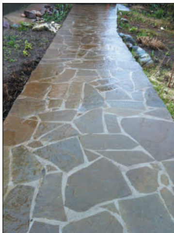
Рис. 67. Использование растворов NVL для укладки природного камня с одновременным заполнением швов (фото предоставлено компанией "Моновай").
