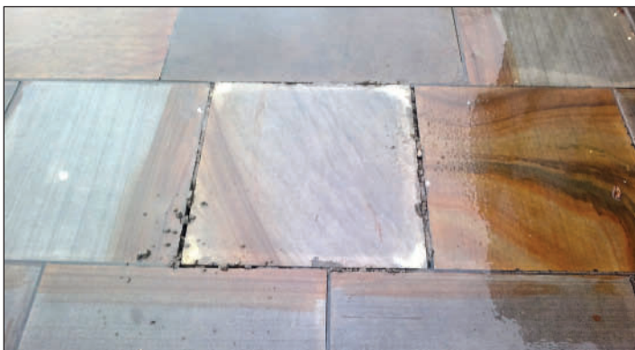
Рис. 9. Крупные плиты не устойчивы в покрытии
