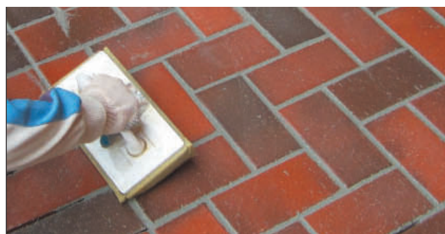
Рис. 29. Пример удаления образовавшихся после очистки мощения излишков воды в швах с помощью губки.
