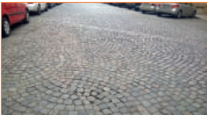
Разрушение мощения на проезжей части в зоне поворота во въезд на территорию двора
