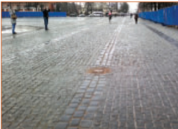
Мощение на центральной городской площади
