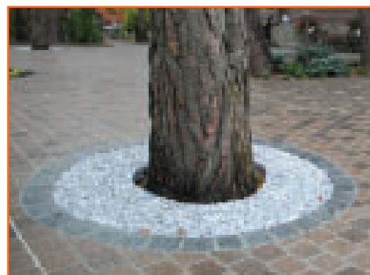
Сдвиг рядов мощения в сторону незакрепленного края зоны растительности
