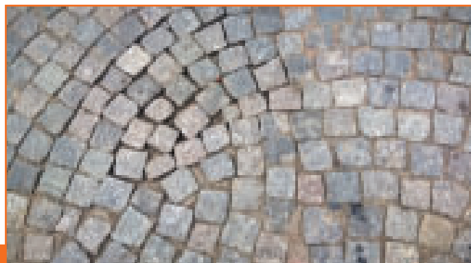
Разрушение мощения на проезжей части в зоне поворота во въезд на территорию двора
