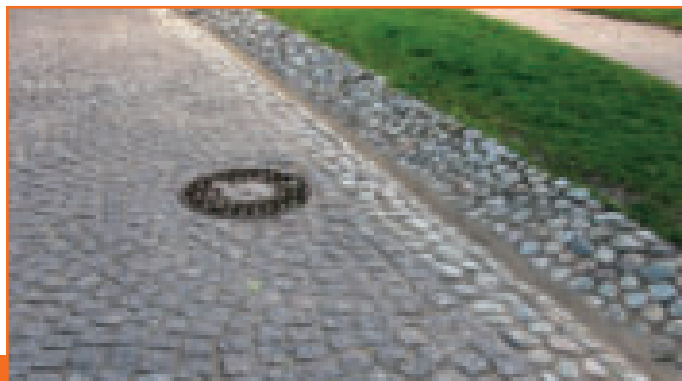
Водосборный канал (лоток) из булыжника
