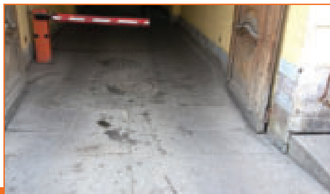
Разрушение покрытия из гранитных плит на въездах -выездах
