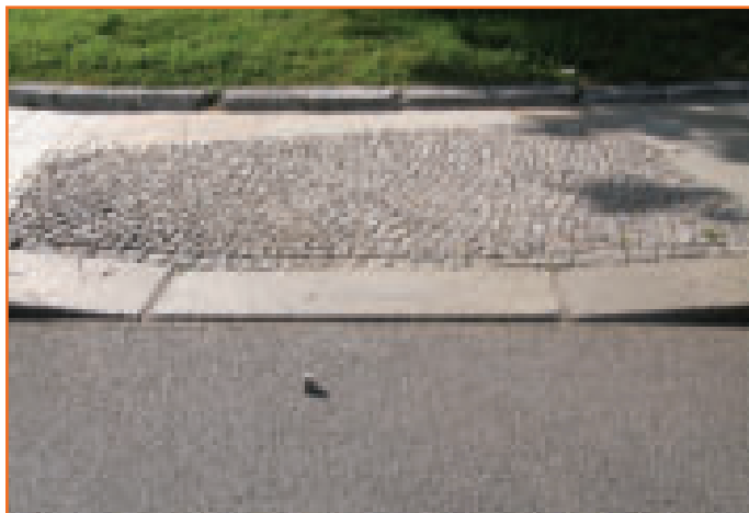
Понижение перед пешеходным переходом из мелкоштучной брусчатки
