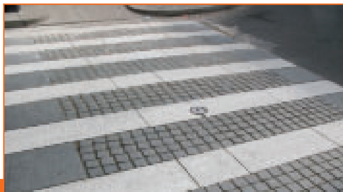
Сдвиг мелкоштучной гранитной шашки в зоне приподнятого пешеходного перехода в направлении поворота колеса
