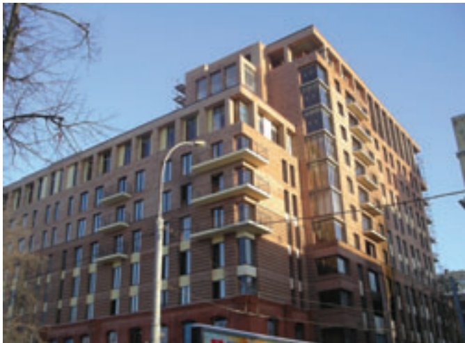
2010 г. Жилой комплекс «Трилогия» г. Москва, ул. Трехгорный Вал, д.14, стр.1 Тонкостенный кирпич ручной формовки. Система «ДИАТ» Исполнитель: «Капиталь». Архитектурная мастерская: «Гинзбург Архитектс»
